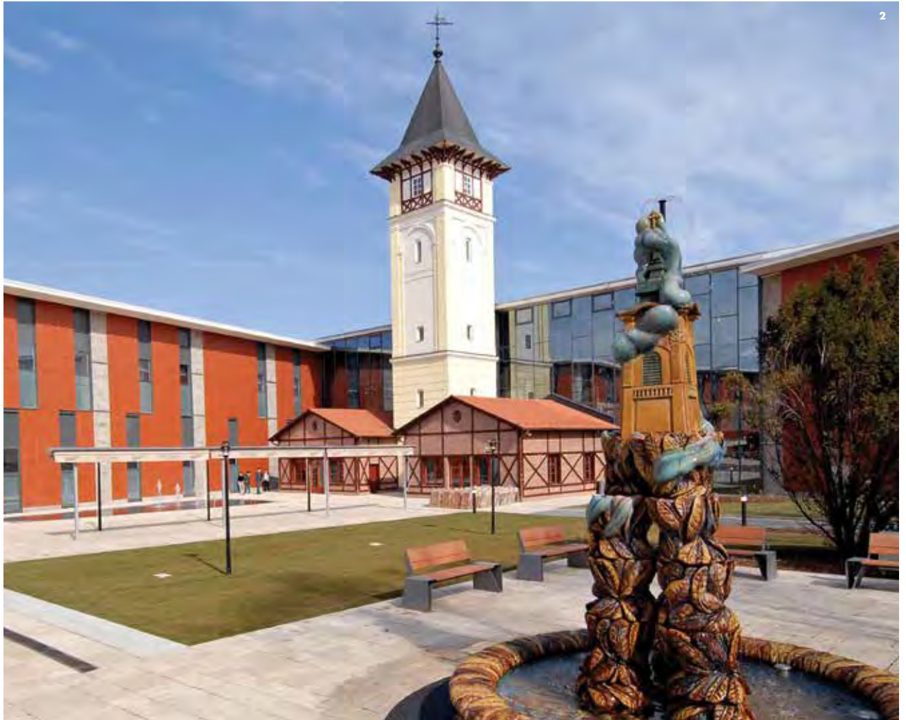
1 MOM Művelődési Központ rekonstrukció, Biopiac és Sirály utcai mélygarázs, Bp. XII. kerület MOM Cultural Center - Reconstruction, Organic Market and Underground Garage in Sirály str., Budapest, XII. MOM Kulturzentrum - Renovierung, Organic Market und Garage in Sirály Str., Budapest, XII.
